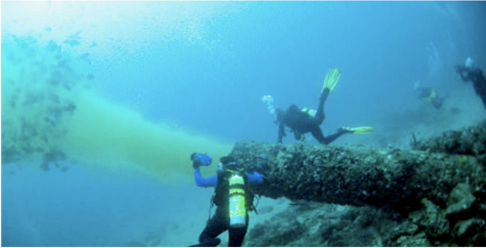
FIG. 3.1 – Écoulement turbulent à la sortie d'une émissaire marin.
