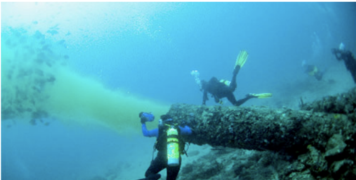
FIG. 3.1 – Écoulement turbulent à la sortie d'une émissaire marin.
